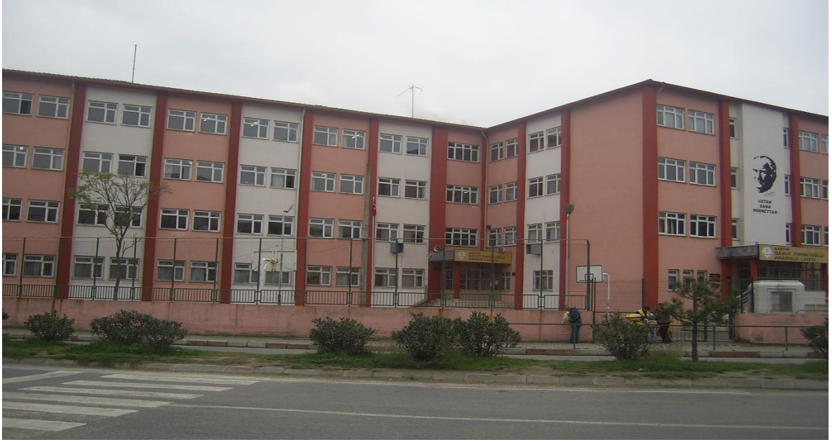
Şekil 3. Davut Fırıncıoğlu Anadolu Lisesi Binası
